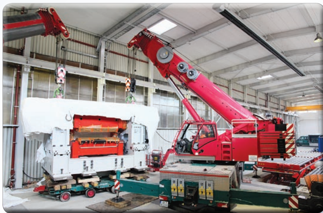
Feinfühlig positionieren die beiden „Indoor-Spezialisten“ eine Exzenter-Schwingschere
