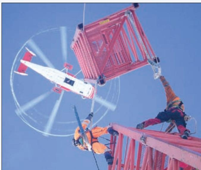
Kapazität der Krane, es wurden auch Störanfälligkeit und Montagefreundlichkeit bewertet, heißt es seitens Wolffkran. Mit den drei Turmdrehkrane mit Hakenhöhen von 24, 78 und 100,5 Metern wurden zwei Liftstützen á 64 und 90 Meter für die neue Pendelbahn errichtet. Die Kranteile wurden per Sattel-LKW ins Fimbatal auf 1.950 Meter Höhe gebracht, dann ging es per Schwerlasthelikopter von Heliswiss International weiter. Insgesamt bewegte der Helikopter rund 200 Tonnen Kranteile durch die Luft.
