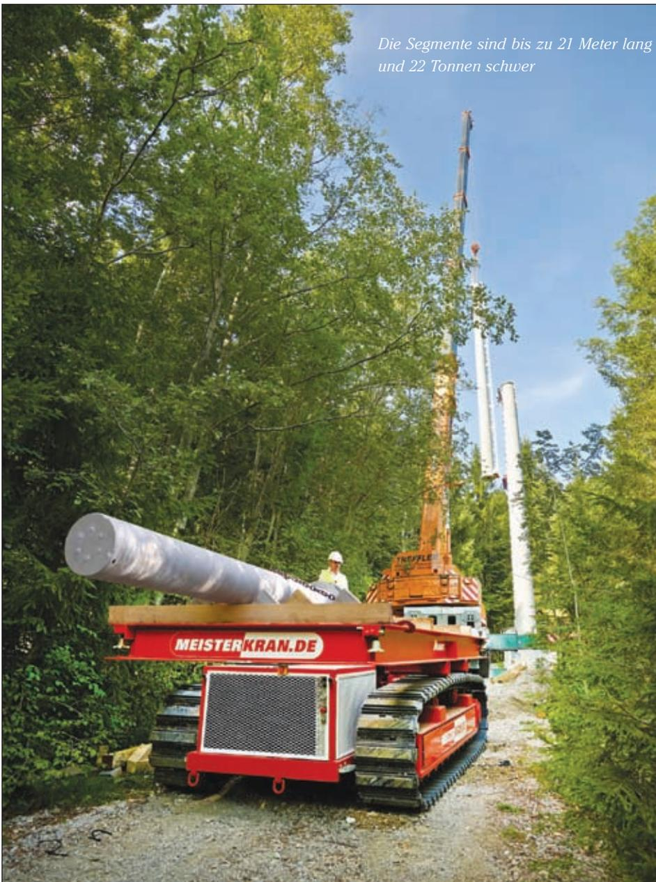
*Die Segmente sind bis zu 21 Meter lang und 22 Tonnen schwer*
