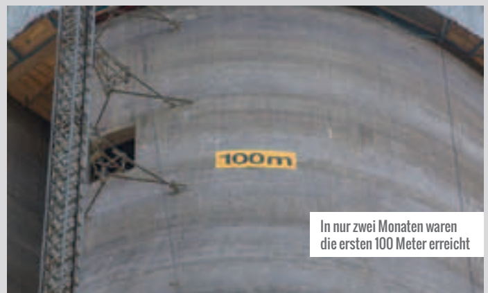
Nur für den Test von Aufzügen in Hochhäusern errichtet Thyssen Krupp den Turm bei Rottweil
