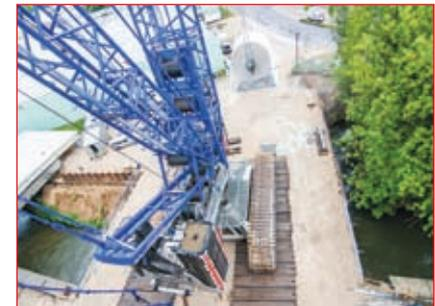
Ein riesiger Stahlzylinder wird in der Papierfabrik Sappi in Alfeld eingehoben. Hauptakteur: ein CC6800 von Maxikraft.
