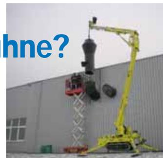
GTplus. An diese Bühne kann ein Kranhaken mit einer Tragfähigkeit von 200 Kilogramm montiert werden. Von einer Scherenbühne aus befestigten die beiden Techniker dann das Lüftungsrohr - nach gut einer halben Stunde war es in der vorgesehenen Halterung fixiert, verschraubt und verklebt. <<
