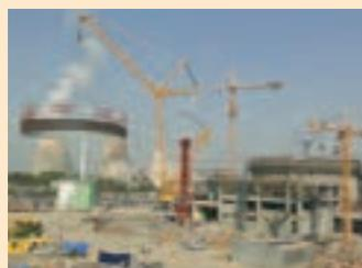
↑ Ein **Liebherr-Raupenkran LR 11350** versetzte einen kompletten Segmentring beim Bau des Reaktorblocks 3 des Kernkraftwerks Kakrapar im Westen Indiens im Bundesstaat Gujarat. Mit einem Durchmesser von rund 50 Metern, einer Höhe von fünf Metern und einem Gesamtgewicht von etwa 170 Tonnen einschließlich dem Gewicht des Rings sowie der Spezialhubvorrichtung war der Ring die wohl größte Kon-
