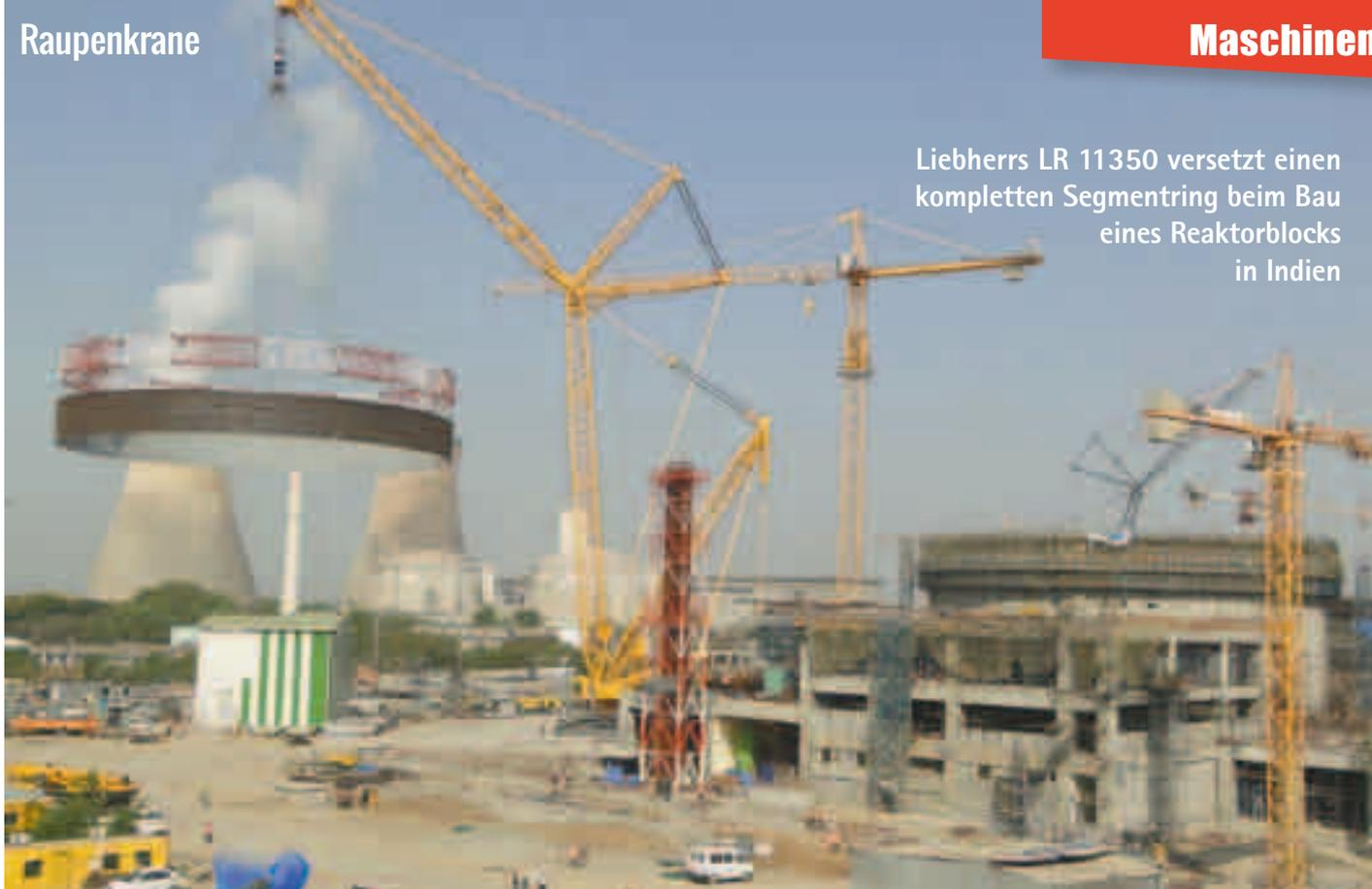
Liebherr LR 11350 versetzt einen kompletten Segmentring beim Bau eines Reaktorblocks in Indien
