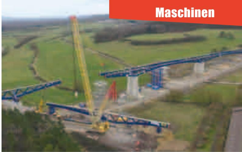
Der Superlift 3800 hebt in Luxemburg eine 96 Meter lange und mit Anschlagmittel 295 Tonnen schwere Brücke ein
