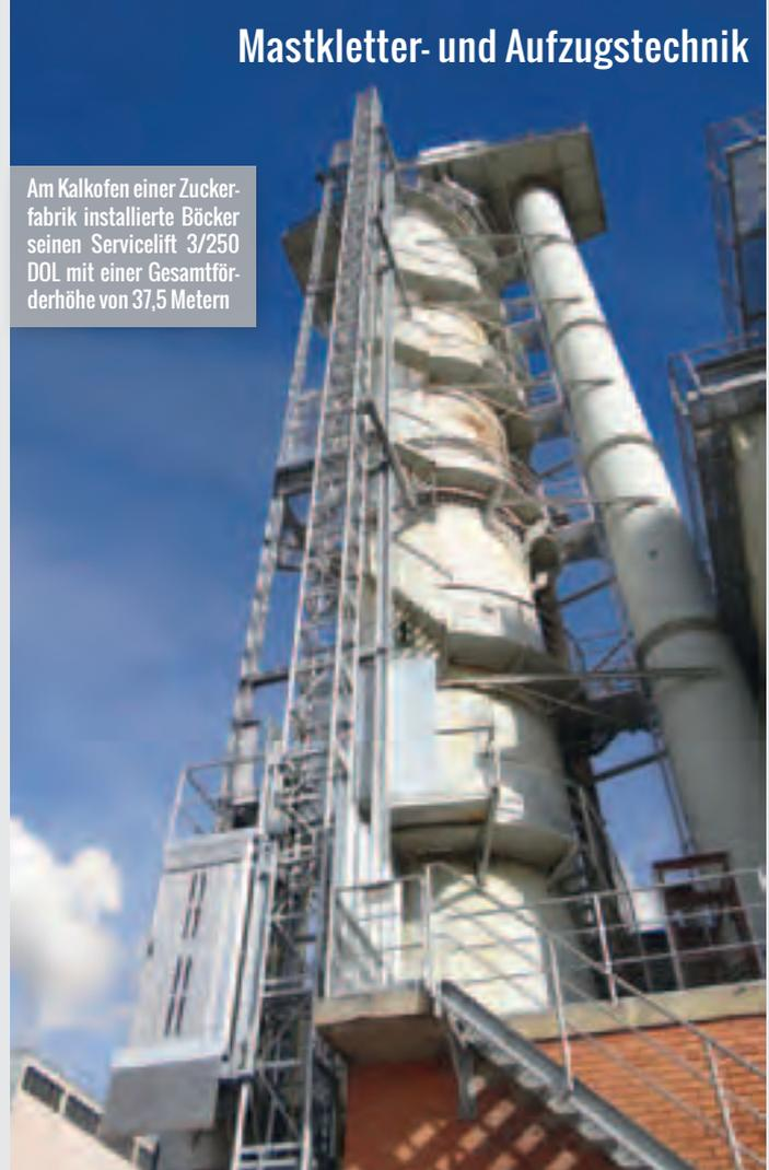
Am Kalkofen einer Zuckerfabrik installierte Böcker seinen Service-lift 3/250 DOL mit einer Gesamtförderhöhe von 37,5 Metern
