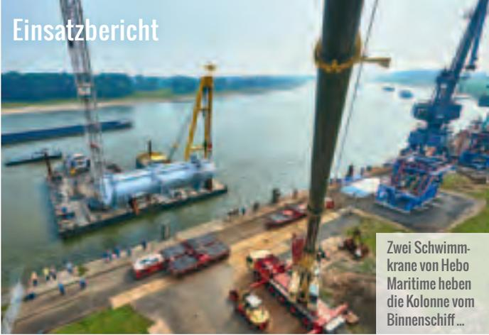
Zwei Schwimmkranne von Hebo Maritime heben die Kolonne vom Binnenschiff...
