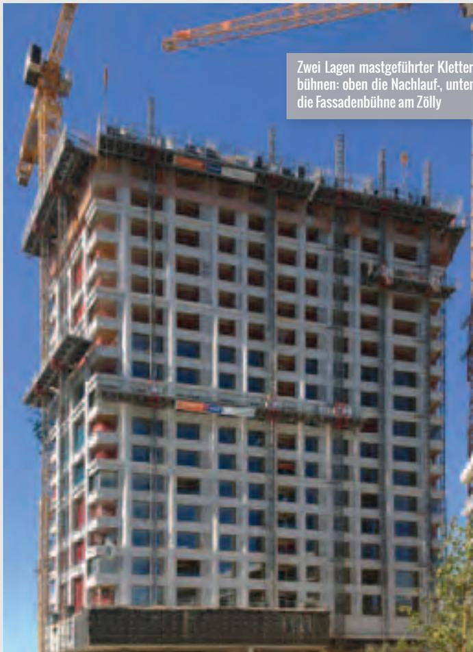
Zwei Lagen mastgeführter Kletterbühnen: oben die Nachlauf-, unten die Fassadenbühne am Zölly
