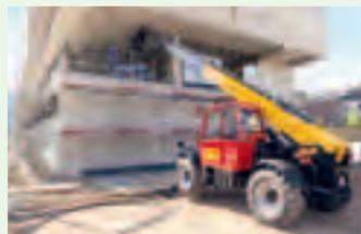
↑ In der Bremer Überseestadt entsteht eine neue Büro- und Wohn-City. An einem fünfstöckigen Neubau montiert die Stahlbaufirma Könenkamp & Eickhoff große Fensterfronten mit Stahlrahmen. Den Materialtransport in die verschiedenen Etagen leistet ein **JLG 3614 RS** Teleskoplader. Der 9,8 Tonne kann auf 14 Meter Höhe Lasten bis zu 3.000 Kilogramm befördern. Dort, wo einst das Herz des Bremer Handels schlug, im Überseehafen, wächst auf 300 Hektar Fläche ein neuer Stadtteil.
