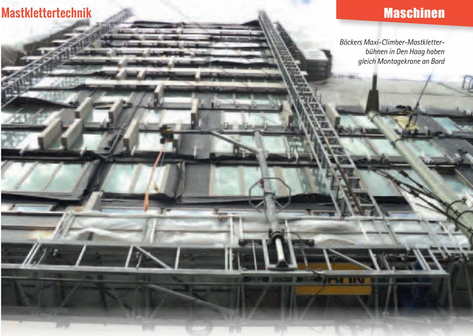
Böckers Maxi-Climber-Mastkletterbühnen in Den Haag haben gleich Montagekrane an Bord
