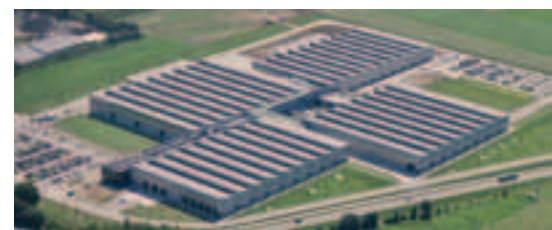
50.000 Quadratmeter überbaute Fläche bietet das Werk in Kaufbeuren
