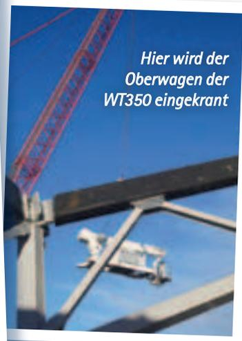
Hier wird der Oberwagen der WT350 eingekrant
