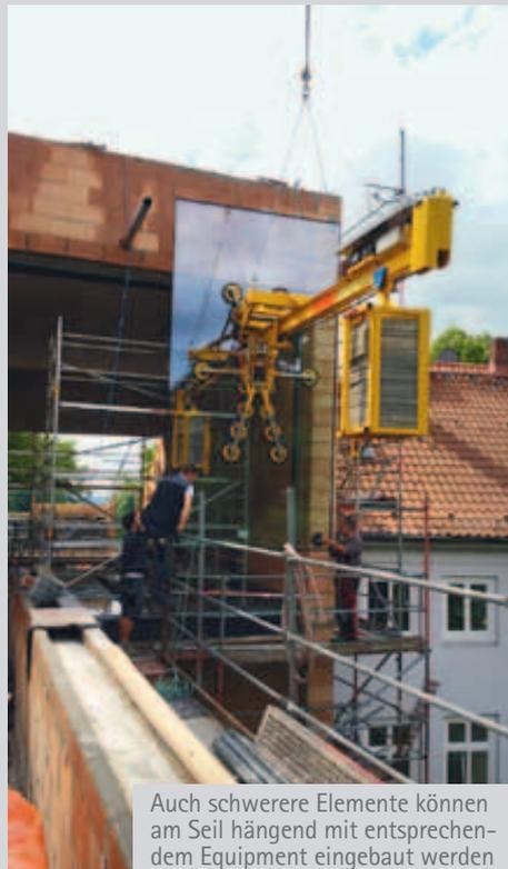
Auch schwerere Elemente können am Seil hängend mit entsprechendem Equipment eingebaut werden
