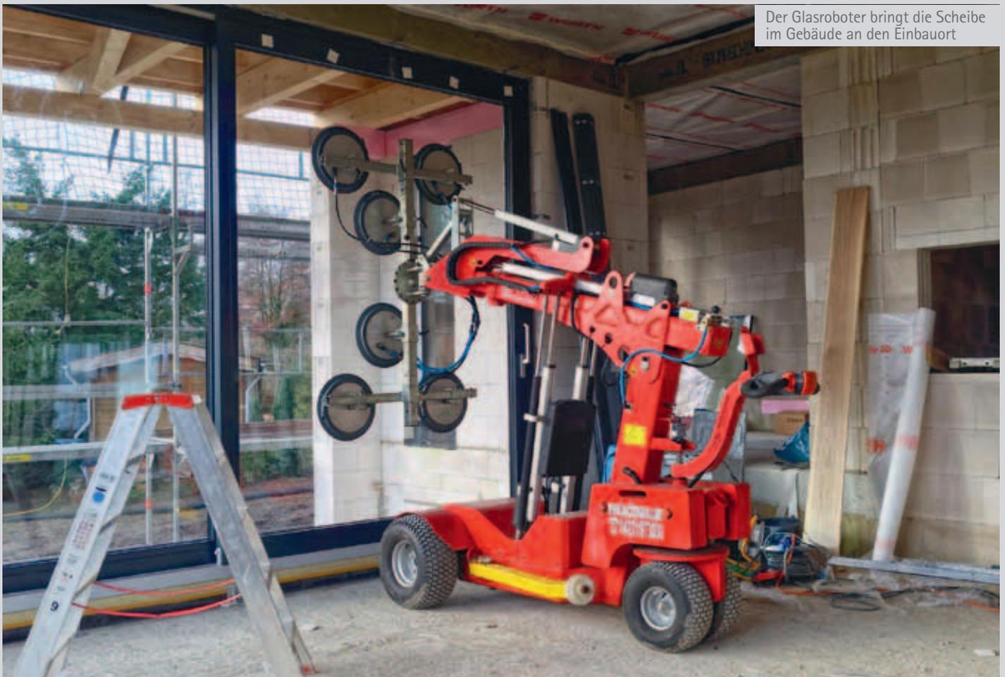
Der Glasroboter bringt die Scheibe im Gebäude an den Einbaort
