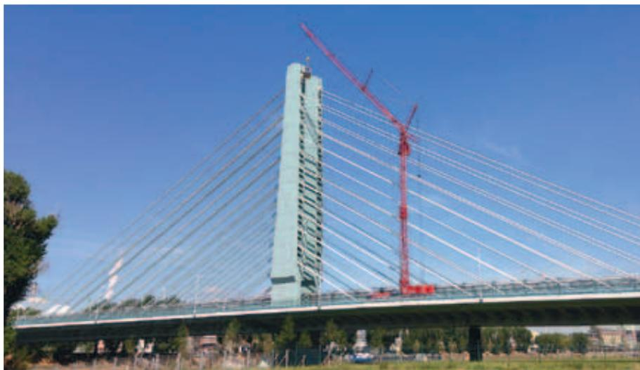
» Um die erste Schrägseilbrücke in Harfenform zu warten, setzte Riga Mainz einen Liebherr MK88 ein. Mit seiner Abstützbreite von 5,75 Metern und einem Eigengewicht von „nur“ 48 Tonnen konnte der MK88 die Brücke befahren und seinen Ausleger steilstellen – und die Experten konnten die Anlage inspizieren.
