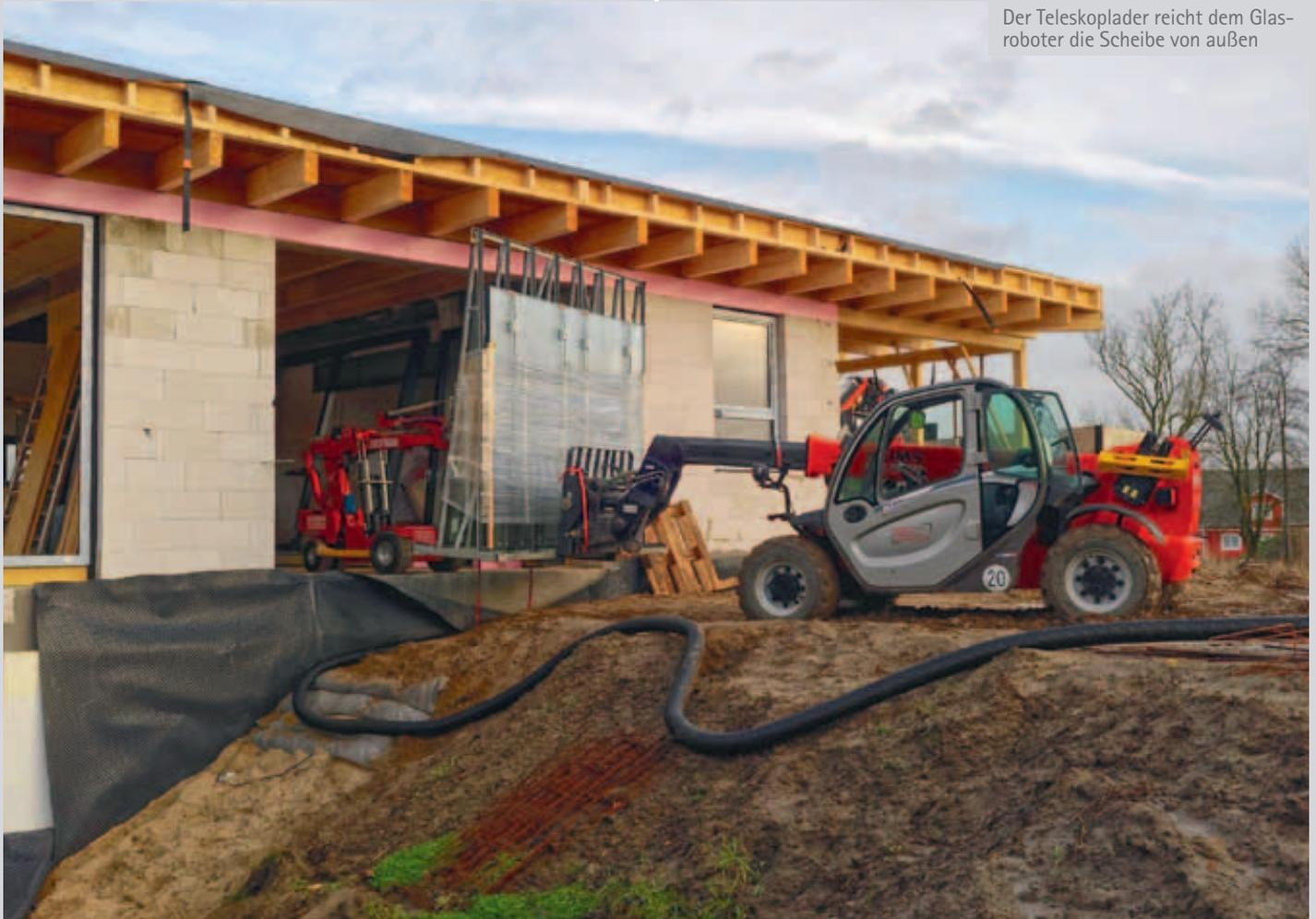
Der Teleskoplader reicht dem Glasroboter die Scheibe von außen
