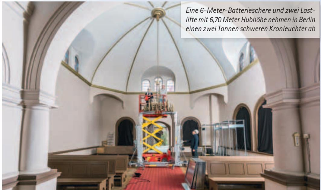
Eine 6-Meter-Batterieschere und zwei Lastlifte mit 6,70 Meter Hubhöhe nehmen in Berlin einen zwei Tonnen schweren Kronleuchter ab
