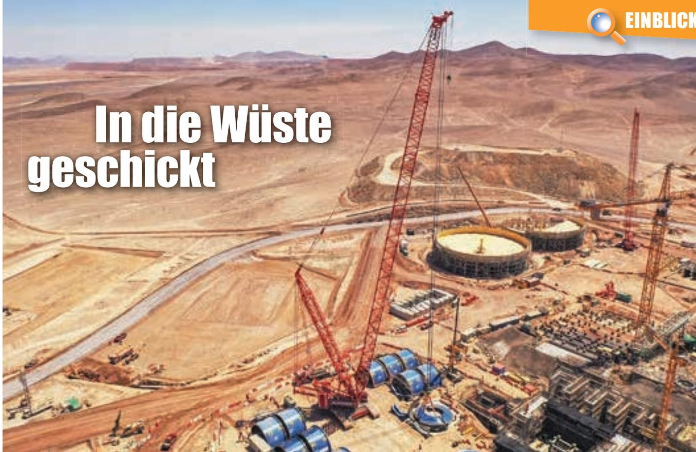
» Ein neuer Liebherr-Raupenkran LR 1750/2 ist vom chilenischen Kranbetreiber Burger Grúas in die Atacama-Wüste im Norden Chiles geschickt worden. Mitten im scheinbaren Nirgendwo wird der Kran für die richtig schweren Lasten eingesetzt und hilft bei der Errichtung der überirdischen Installationen einer Mine. Er arbeitet
