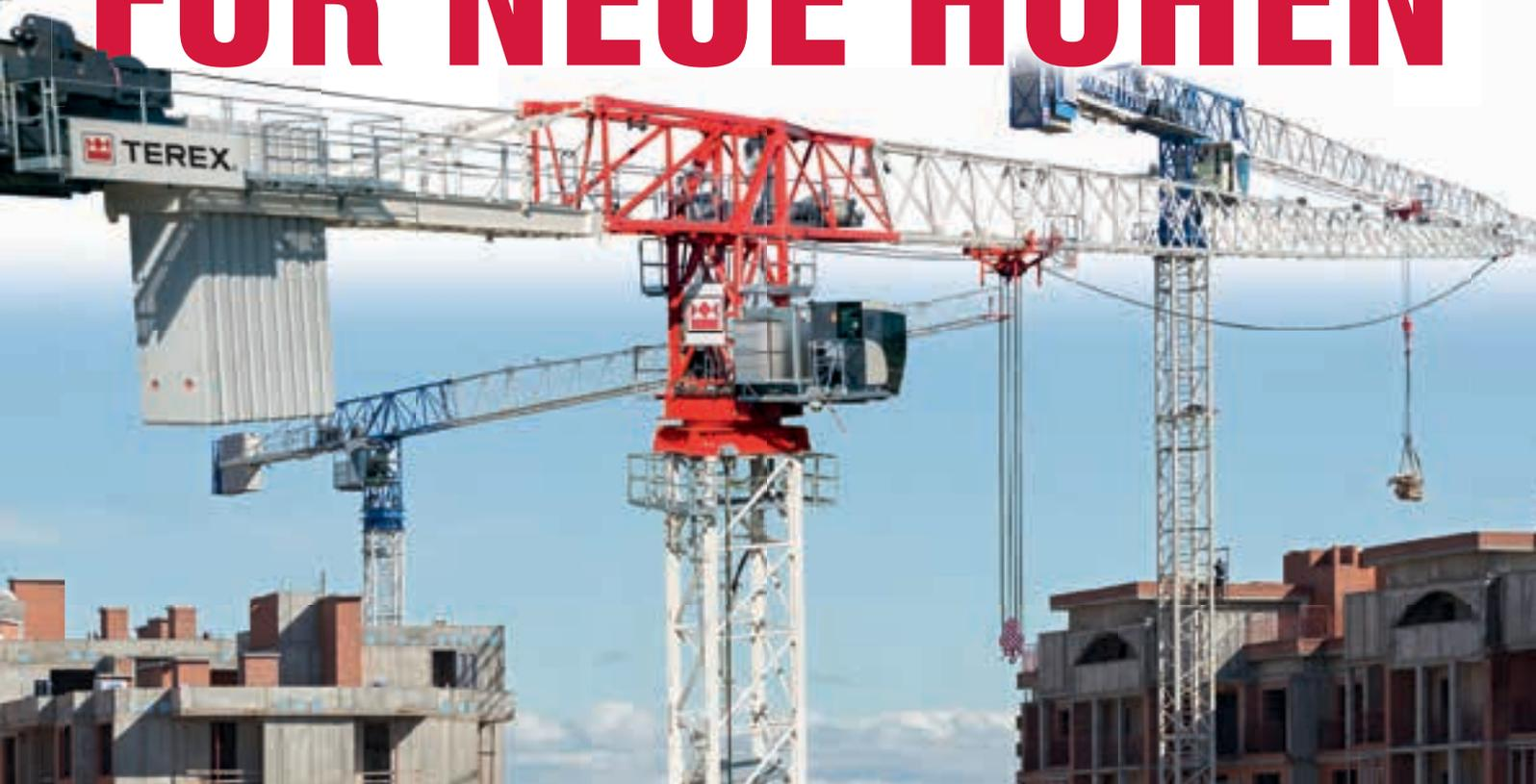
CTT 472-20 Flat Top | 20 t maximale Tragfähigkeit; 4 t am Auslegerende
