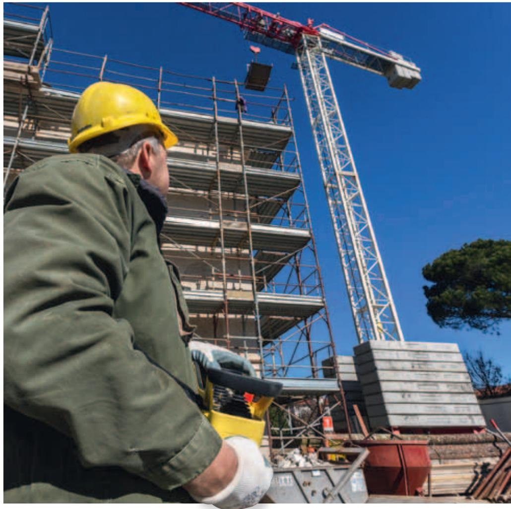
Wie bei den anderen Herstellern werden auch die Steuerungen von **Ikusi** nach Kundenwunsch konfiguriert, egal ob aus der T-Sender-Serie oder aus der IK-Baureihe. Für Letztere ist neu die sogenannte „Ikugraph“-Funktion zu haben: Per Drag & Drop, also mit der Maus, sucht man sich am Bildschirm die Funktionen und Symbole aus, die man auf seiner Fernsteuerung
