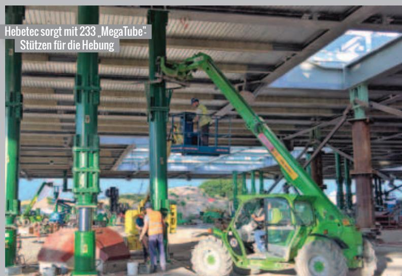
Hebetec sorgt mit 233 „MegaTube“ Stützen für die Hebung
