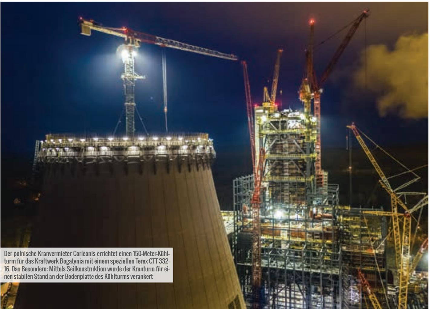
Der polnische Kranvermieter Corleonis errichtet einen 150-Meter-Kühlturm für das Kraftwerk Bogatynia mit einem speziellen Terex CTT 332-16. Das Besondere: Mittels Seilkonstruktion wurde der Kranturm für einen stabilen Stand an der Bodenplatte des Kühlturms verankert
