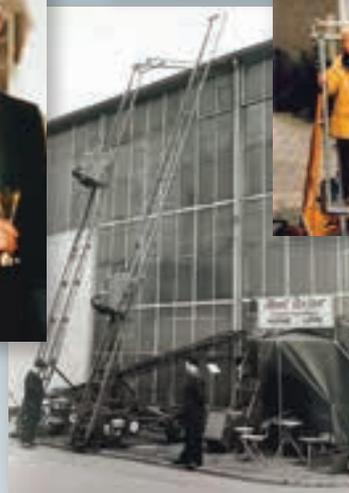
Die Entwicklung des Schrägaufzuges mit doppeltem Knick war wegweisend für den Werdegang der Firma
