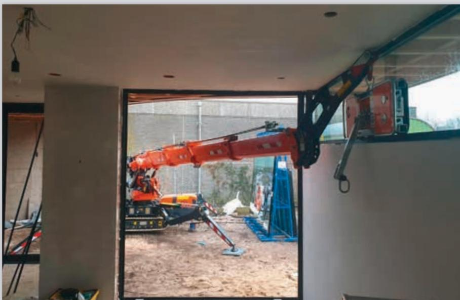
Für den Einbau eines großen Oberlichts kam ein Minikran des Typs Jekko SPX532 zum Einsatz. Um das Glaselement bis unter die Decke einheben zu können, wurde ei-
