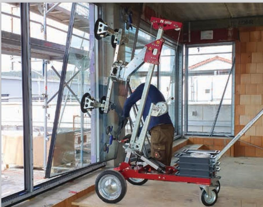
Uplifter hat den UPT 250 neu entwickelt, der leicht zu transportieren ist sowie schnell und komfortabel von einem Stock in den anderen befördert werden kann. Demontiert kann das Montagegerät UPT 250 im Auto zur Baustelle gebracht werden. Ohne große Vorkenntnisse ist es laut Unternehmen innerhalb von zwei Minuten
