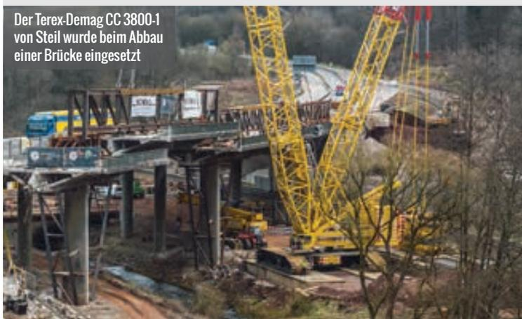
Der Terex-Demag CC 3800-1 von Steil wurde beim Abbau einer Brücke eingesetzt
