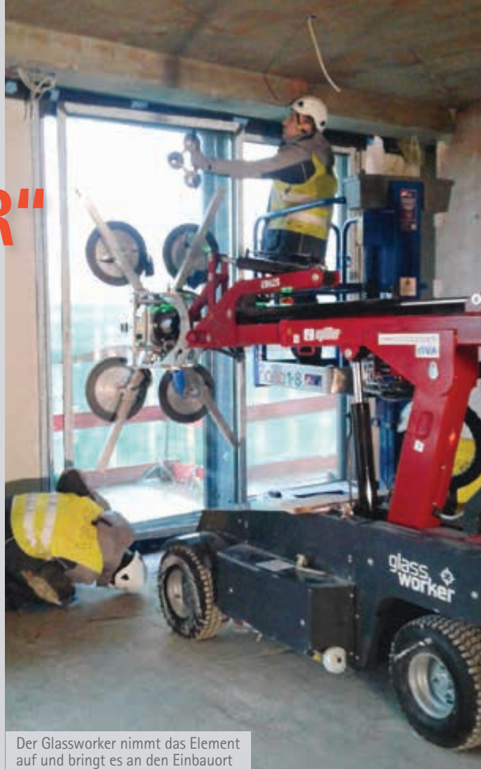
Um das Fassadenelement in Raumhöhe drehen und bewegen zu können, wird das Bauteil nach vorne geneigt
