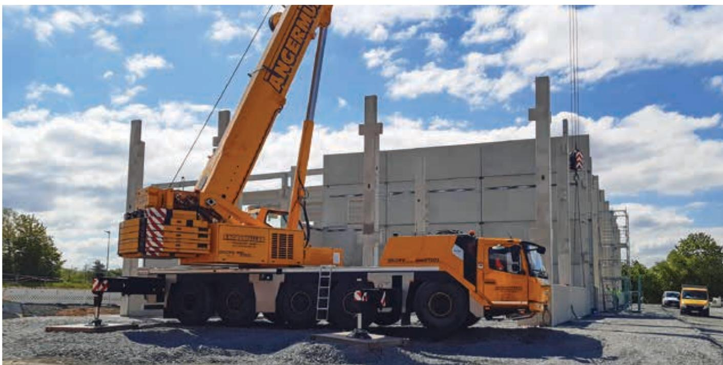
Die Baufirma Angermüller aus dem oberfränkischen Untersiemau nahe Coburg hat ihren Grove GMK5130-2 nach zehn Jahren gegen einen GMK5150L ausgetauscht. Der neue 5-Achser erzielt gegenüber dem vorigen Modell eine Traglaststeigerung von 20 Prozent. Mittlerweile ist der 150-Tonner nun seit fast einem Jahr pausenlos im Einsatz: Zuletzt hat er auf einer Baustelle in Bayreuth 8,5 Tonnen schwere Wandplatten auf 24 Meter Radius gesetzt. <<
