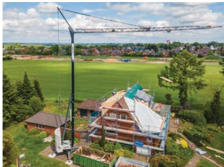
Das familiengeführte Generalunternehmen Heims Holzbau aus Drage bei Hamburg hat gleich drei neue Schnelleinsatzkrane L1-32 bei Liebherr bestellt. Mit 30 Metern Ausladung, einer standardmäßigen Hakenhöhe von 21,30 Metern und einer maximalen Tragkraft von vier Tonnen passte für Benjamin Heims, den Geschäftsführer des gleichnamigen Holzbaunternehmens, die Größe des Untendrehers optimal.
