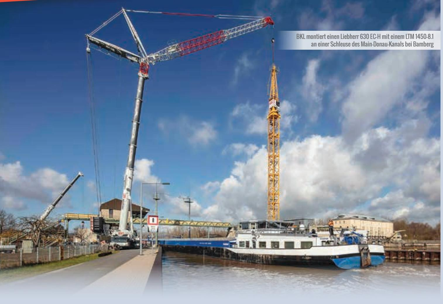
BKL montiert einen Liebherr 630 EC-H mit einem LTM 1450-8.1 an einer Schleuse des Main-Donau-Kanals bei Bamberg
