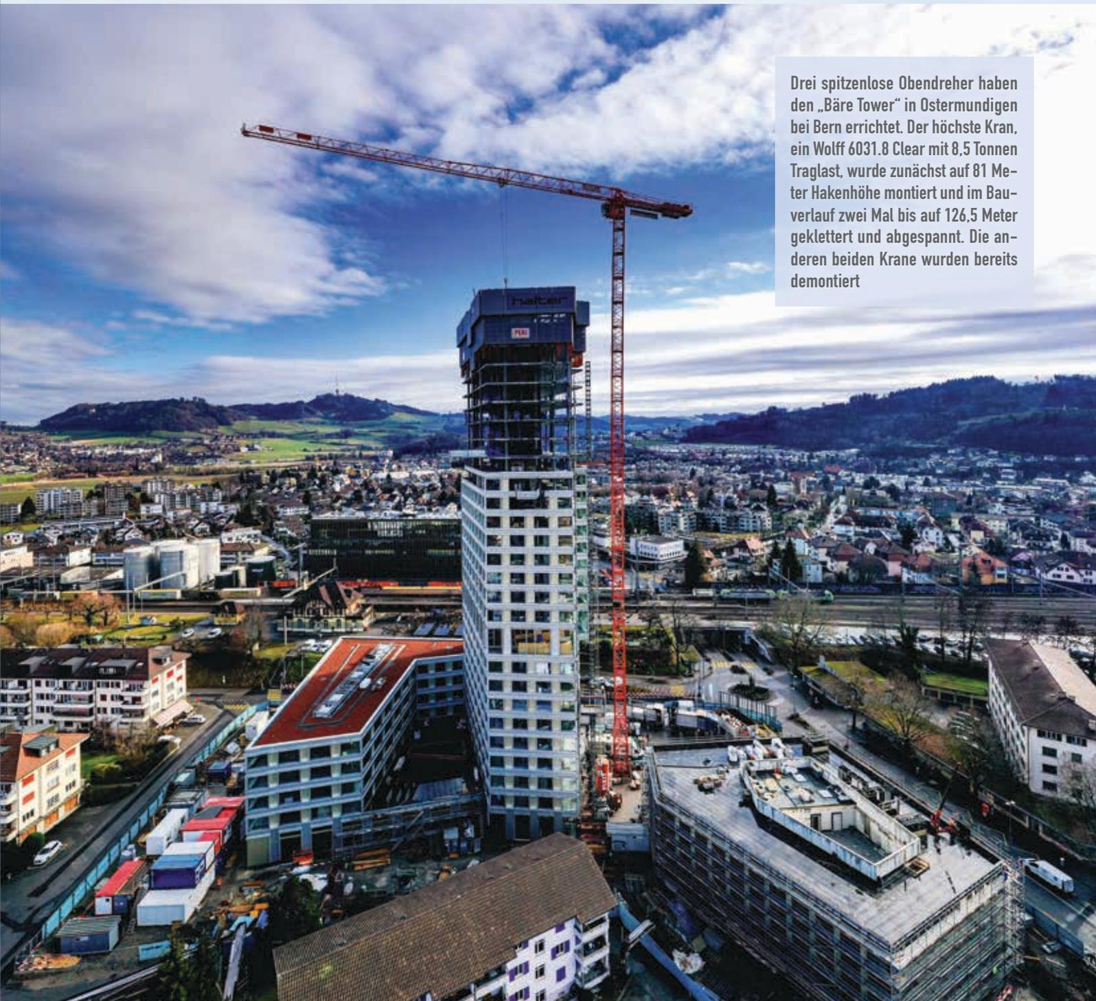
Drei spitzenlose Obendreher haben den „Bäre Tower“ in Ostermündigen bei Bern errichtet. Der höchste Kran, ein Wolff 6031.8 Clear mit 8,5 Tonnen Traglast, wurde zunächst auf 81 Meter Hakenhöhe montiert und im Bauverlauf zwei Mal bis auf 126,5 Meter geklettert und abgespannt. Die anderen beiden Krane wurden bereits demontiert
