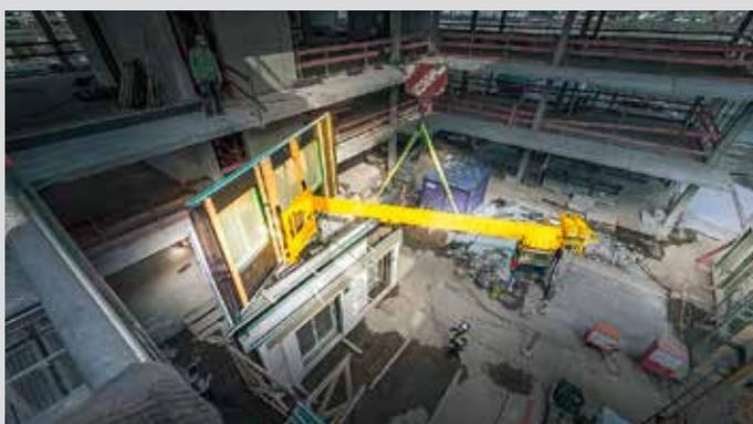
Denn die Saugteller sind zwar flexibel verstellbar, aber sie können nicht an den Rahmenprofilen ansaugen. „Eine Montage mit einer Sauganlage hätte für uns einen erheblichen Einstellungsaufwand vor Ort bedeutet. So haben wir eine Kontertraverse mit Gabelaufnahme entwickelt, mit der die Last immer senkrecht ausgerichtet ist“, erklärt Heavydrive-Geschäftsführer Günter Übelacker.
