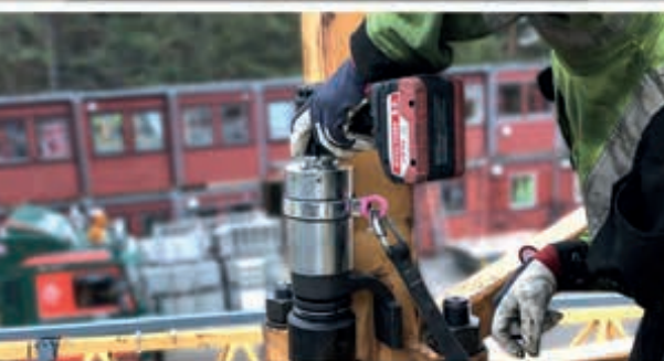
Drehschrauber ADS 600 Eckstielverbindung M45, M A = 5.850 Nm
