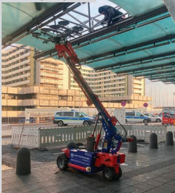
Auch Ladekrane mit passenden Sauganlagen werden für die Installation von Scheiben bei Hüffermann eingesetzt
