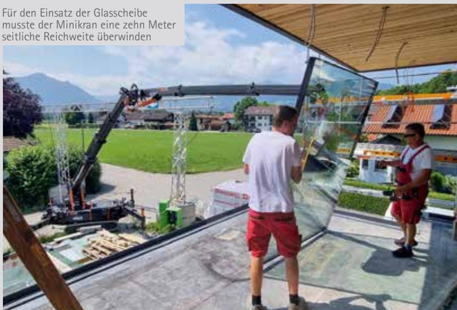
mann Jonuz, einem Minikran und dem passenden Vakuumglassauger: „Für Glasarbeiten in bis zu 21 Metern Höhe wird noch kein Baukran benötigt. Die Minikrane von BG Lift sind dafür sehr praktisch, da sie platzsparend und schnell aufgebaut und sehr sanft gesteuert werden können.“ Das Team von Kunze setzt dabei auf Glassauger des niederländischen Unternehmens Grip Vacuum Lifting.
