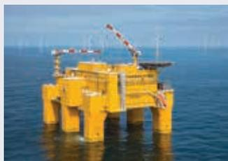
↑ Einen Offshore-Kran RL 2600 für die Konverterplattform *Dol-Win Epsilon* auf dem Schiff *UHL Felicity* hat **Liebherr** erfolgreich nach Singapur verschifft. Netzbetreiber Tennet hat Aibel mit dem Bau der Offshore-Konverterplattform in der deutschen Nordsee beauftragt. Hier wird der Kran für die Versorgung und Wartung der Plattform zum Einsatz kommen. Der RL 2600 verfügt über einen Kastenausleger mit einer maximalen Arbeitsreichweite von 52 Metern und einer Tragfähigkeit von bis zu 35 Tonnen.
