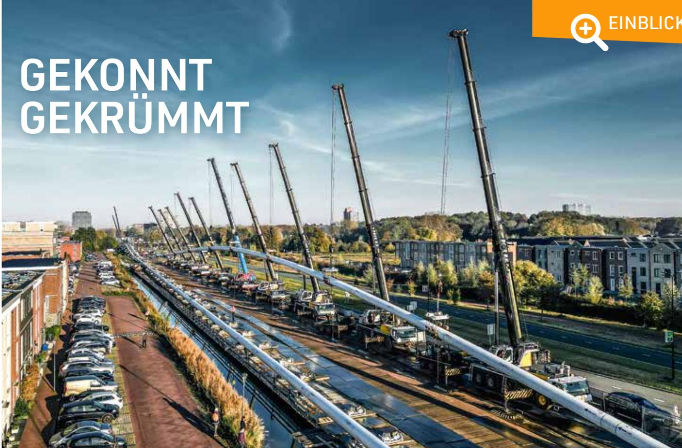
→ Zwölf Mobilkrane mit Tragkräften waren beim Bau einer Pipeline im niederländischen Delft im Einsatz. Die Mobilkrane hoben eine Rohrleitung von insgesamt einem Kilometer Länge an, um sie in die richtige Position für die Einführung ins Erdreich zu bringen. Um die genaue Krümmung hinzubekommen, formen zehn Krane den 275 Meter langen Einziehbogen. Sie haben Traglasten von 90 bis 140 Tonnen. Ergänzt wird das Line-Up von zwei Autokranen mit
