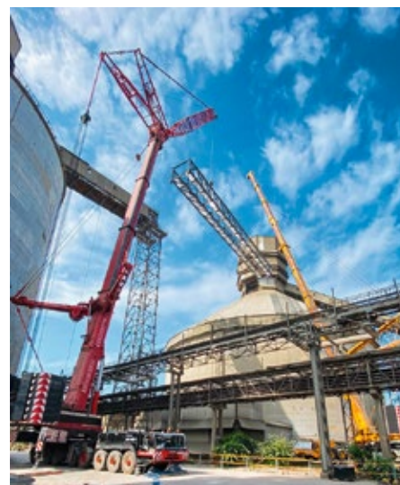
50 Meter lang, 50 Tonnen schwer: Zwei Tadano-Krane, ein AC 1000-9 und ein AC 500-1, heben in Indien einen Stahlrahmen für ein Förderband zwischen zwei Silos ein
