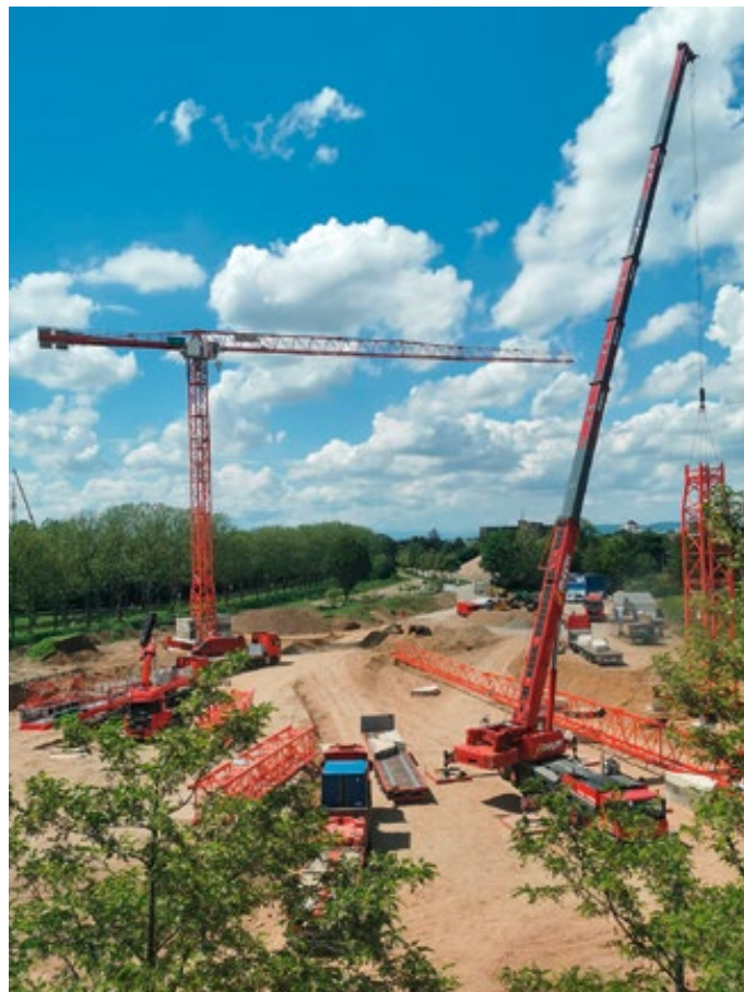
In Freiburg wurden zwei Wolff montiert zur Erweiterung des Rathauses
