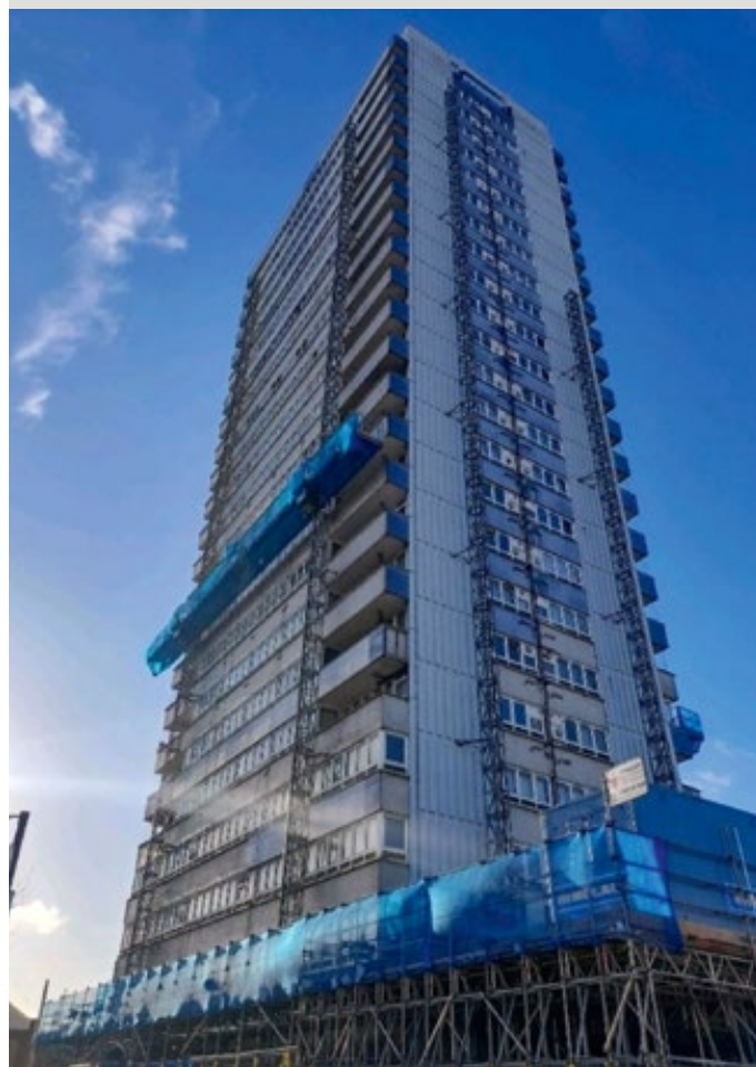
Die Mastkletterbühnen Twin Goian GP40 von Jaso sind in London vielfach im Einsatz. Hier geht es um die Instandsetzung einer Betonaußenfassade im Stadtteil Stratford
