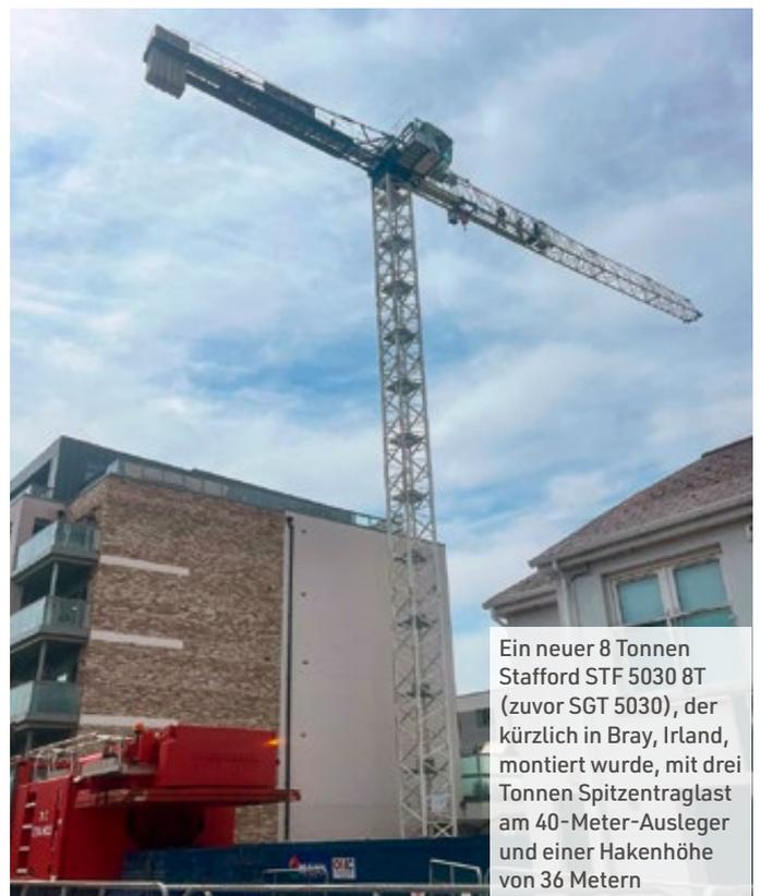
Ein neuer 8 Tonnen Stafford STF 5030 8T (zuvor SGT 5030), der kürzlich in Bray, Irland, montiert wurde, mit drei Tonnen Spitzentraglast am 40-Meter-Ausleger und einer Hakenhöhe von 36 Metern
