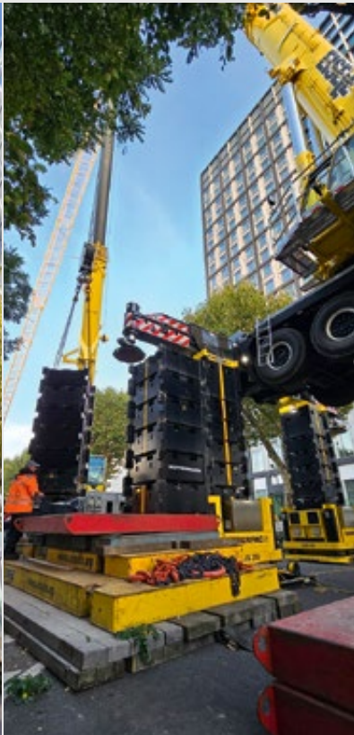
Der Hilfskran platziert die Barrel-Blöcke unter der Abstützung
