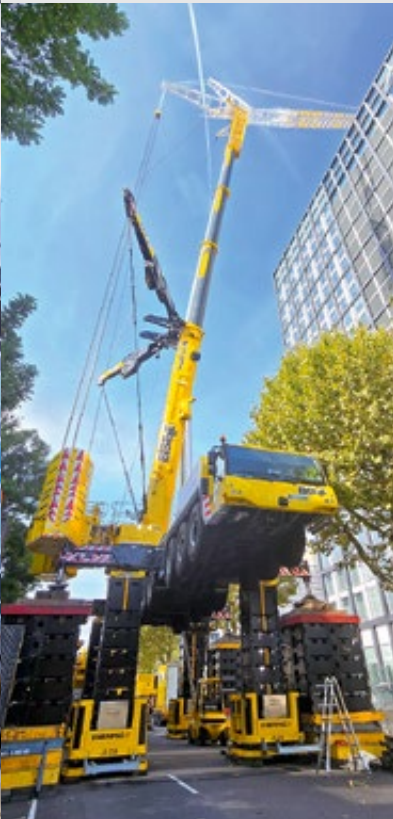
Der aufgebockte Kran
