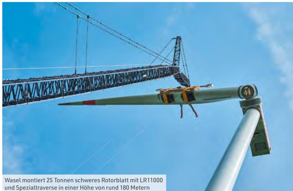
Wasel montiert 25 Tonnen schweres Rotorblatt mit LR11000 und Spezialtraverse in einer Höhe von rund 180 Metern
