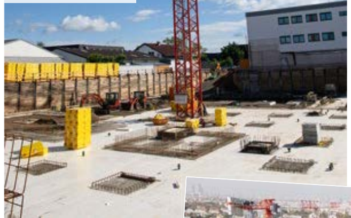
Erster Einsatz des neuen Großkrans BBL 8040.20/2 in Troisdorf, Neubau Büro- und Werkstattgebäude
