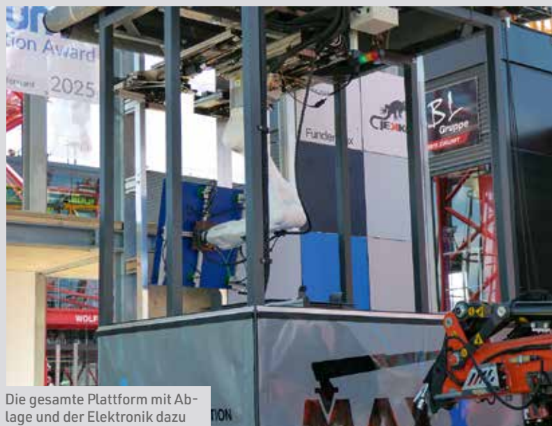
... platziert diese an die entsprechende Stelle der Fassade
