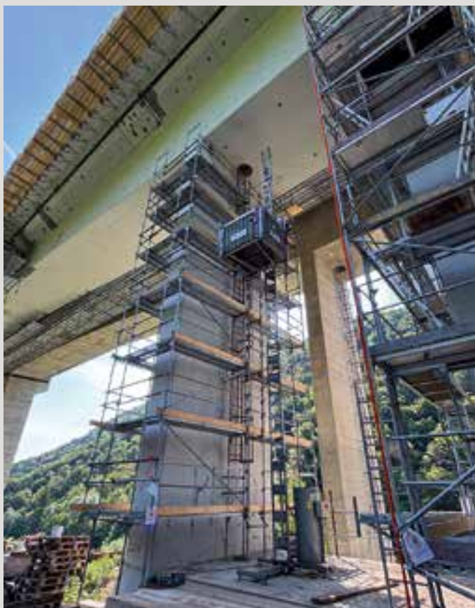
Für die Sanierung der beiden Brücken Skedenj bei Maribor kommen Geda-Aufzüge zum Einsatz
