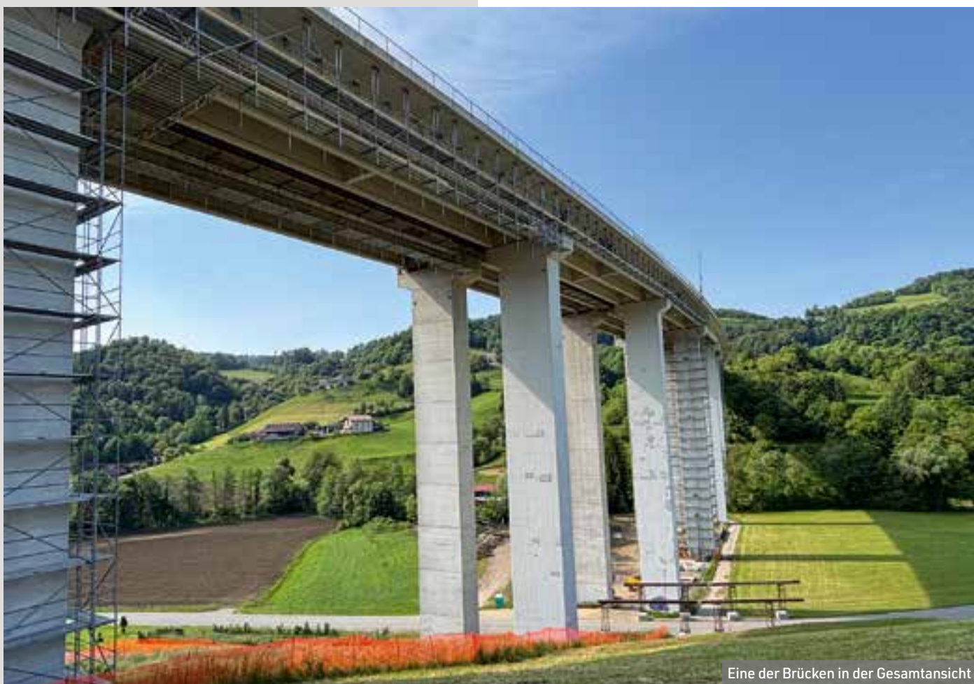
Für die Sanierung der beiden Brücken Skedenj bei Maribor kommen Geda-Aufzüge zum Einsatz
