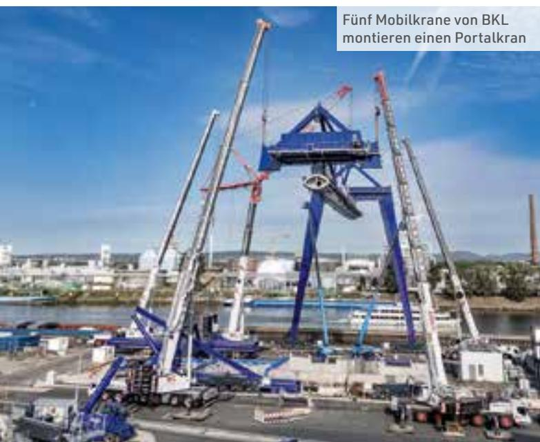
Fünf Mobilkrane von BKL montieren einen Portalkran
