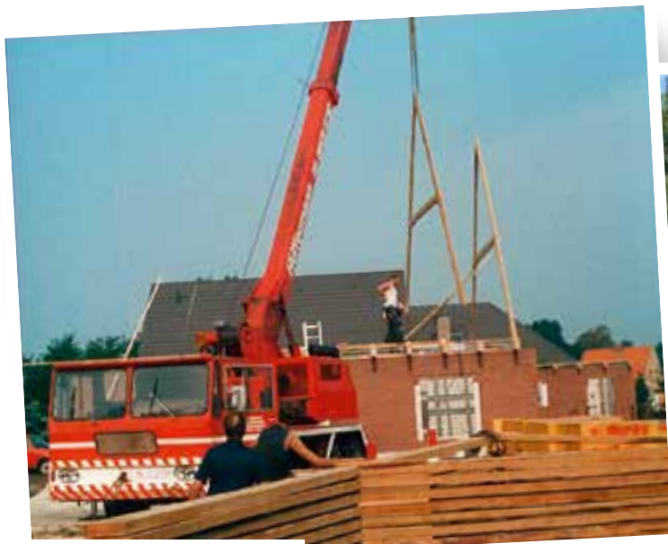
Fidi Ehlers in den 80er Jahren mit dem 25-Tonnen-Gottwald-Kran beim Setzen eines Dachstuhls
