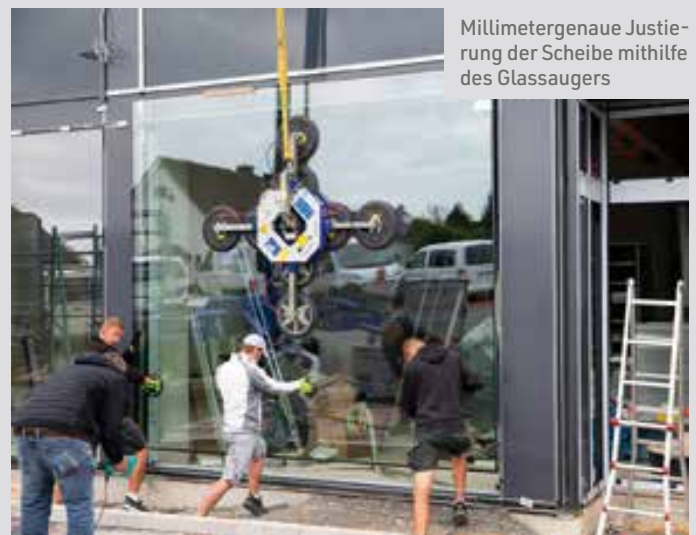
Der Minikran positioniert das Glaselement passgenau in die Fassadenöffnung
