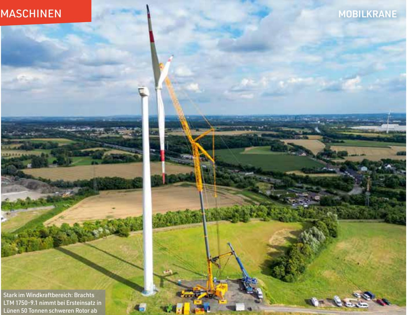
Stark im Windkraftbereich: Brachts LTM 1750-9.1 nimmt bei Ersteininsatz in Lünen 50 Tonnen schweren Rotor ab
