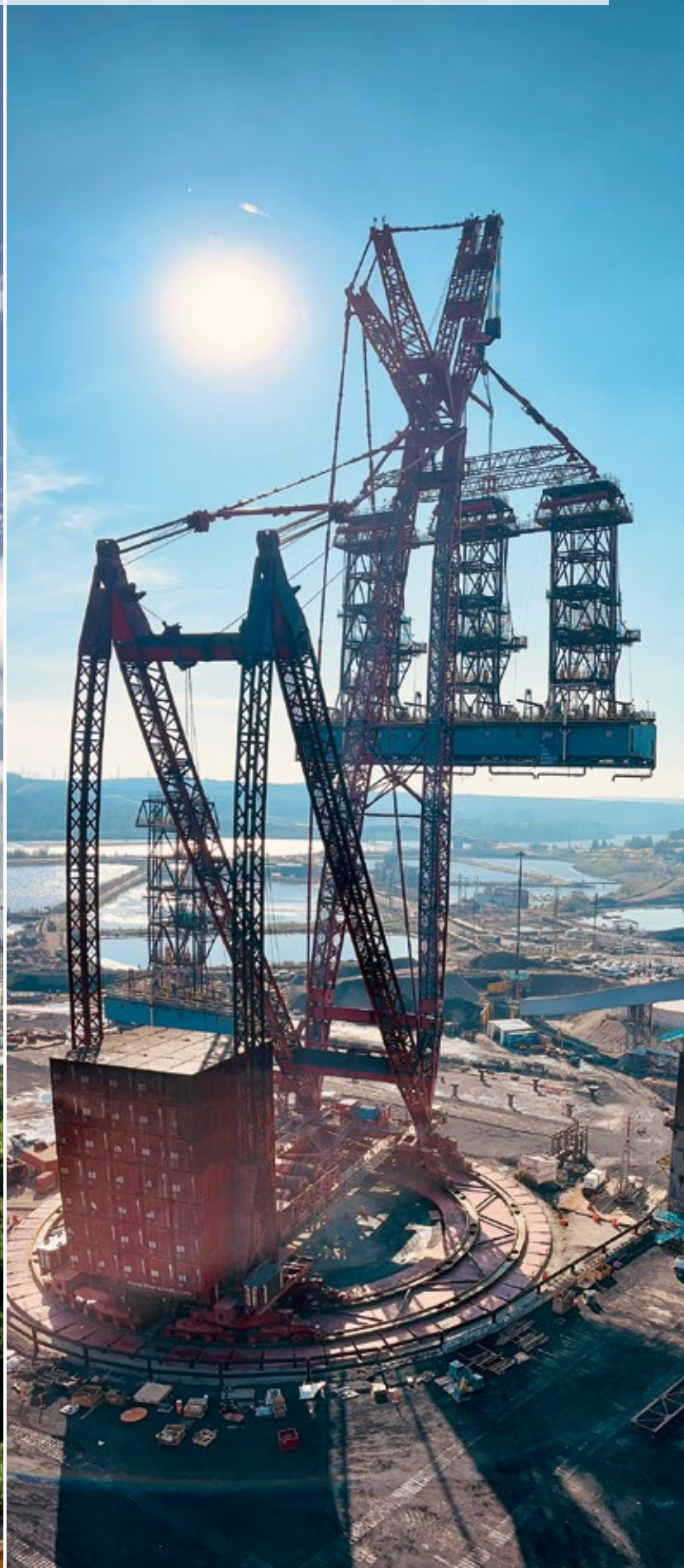
Acht Kokstrommeln à 270 Tonnen werden getauscht mit dem PTC210DS in Fort McMurray, Kanada: die schwerste Last wog 1.200 Tonnen
