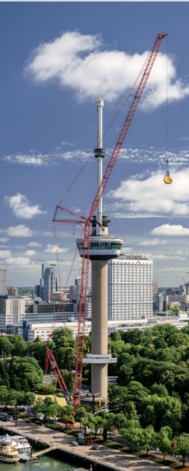
Mammoets CC 38.650-1 entfernt acht Meter große Lettern am Euromast-Turm in Rotterdam
