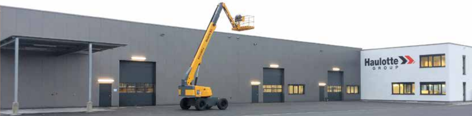
Der Standort von Haulotte Deutschland mit Werkshalle
