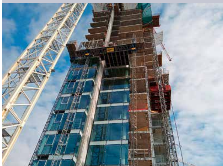
Die Mastkletterbühnen verfügen über spezielle Teleskop-Ausfahrvorrichtungen
